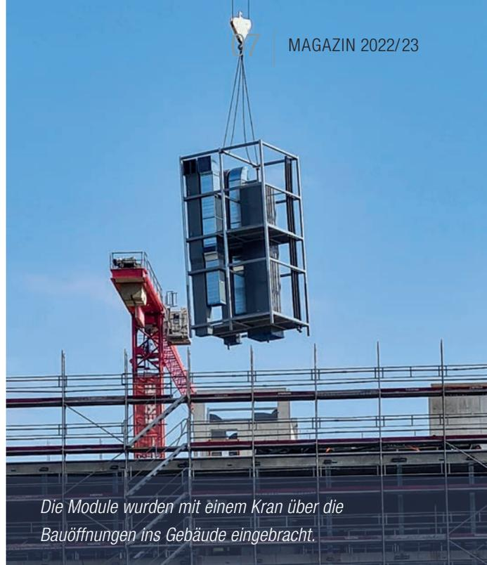
*Die Module wurden mit einem Kran über die Bauöffnungen ins Gebäude eingebracht.*
