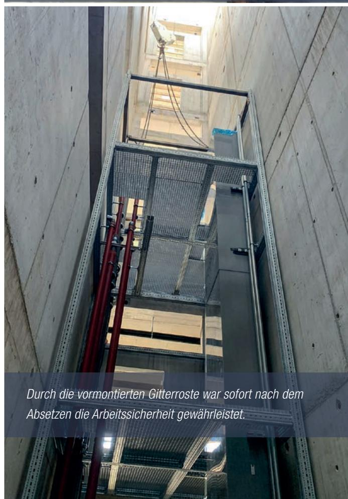
*Durch die vormontierten Gitterroste war sofort nach dem Absetzen die Arbeitssicherheit gewährleistet.*
